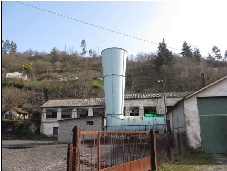
Fotografía 6-5.- Vista del Pozo Barredos, fotografía tomada en el año 2011.
