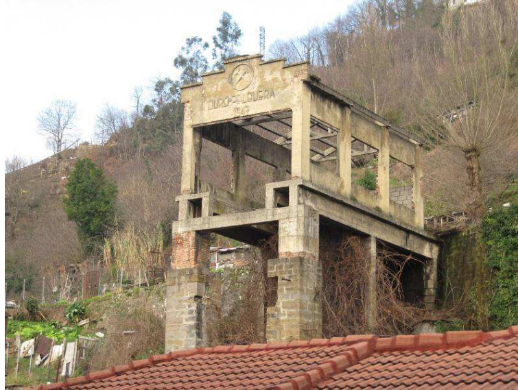
Fotografía 6-3.- Vista de instalaciones aún conservadas del entorno del Pozo Rimadero, fotografía tomada en el año 2011.
