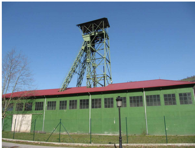
Fotografía 6-2.- Vista del Pozo San Mamés, fotografía tomada en el año 2011.
