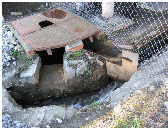
Fotografía 11-2.-Canal de vertido del Pozo Fondón.
