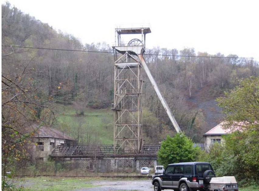
Fotografía 6-1.- Vista del pozo Cerezal, fotografía tomada en el año 2009.
